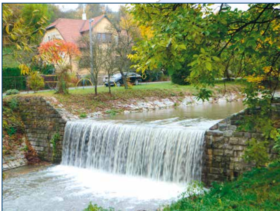
VVT Brumovka řkm 2,855 - stupeň po opravě
