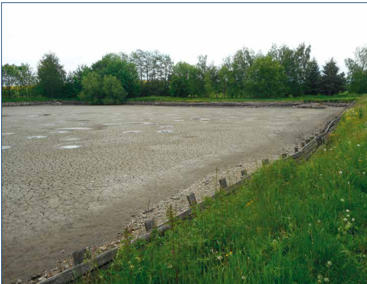
Vodní nádrž Roštění po vypuštění
