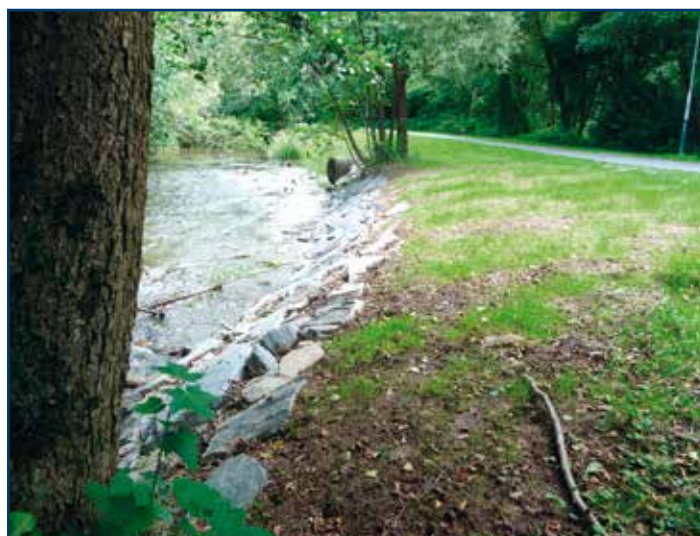
Opravená LB nátrž na Bystřici v Hlubočkách
