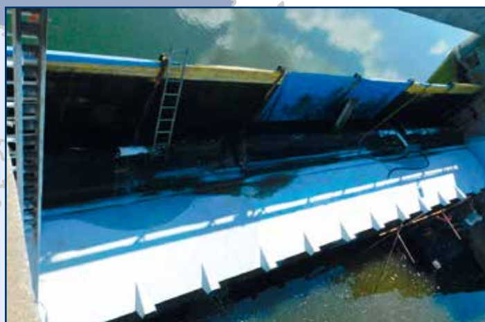
Oprava těsnění na jezu Osek
