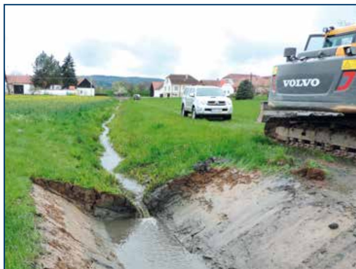
Průběh těžení nánosů
