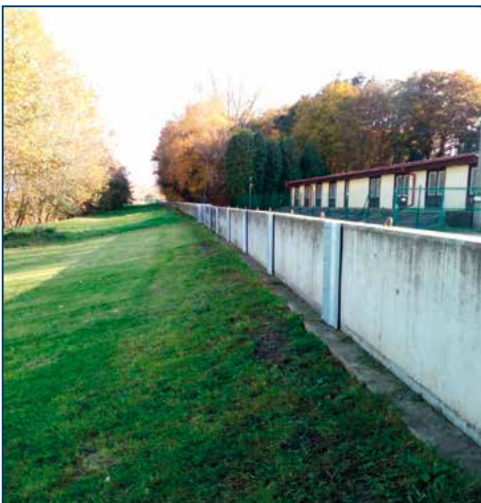
Oprava betonové zdi v Kojetíně
