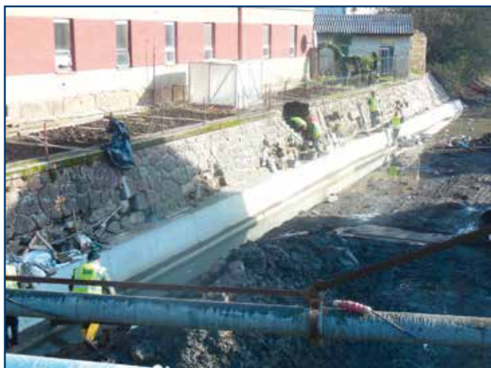
Oprava opěrných zdí řeky Svitavy ve Svitávce
