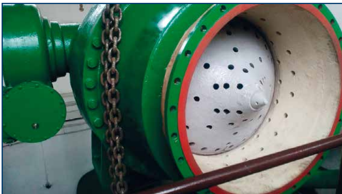
Montáž opraveného kuželového uzávěru
