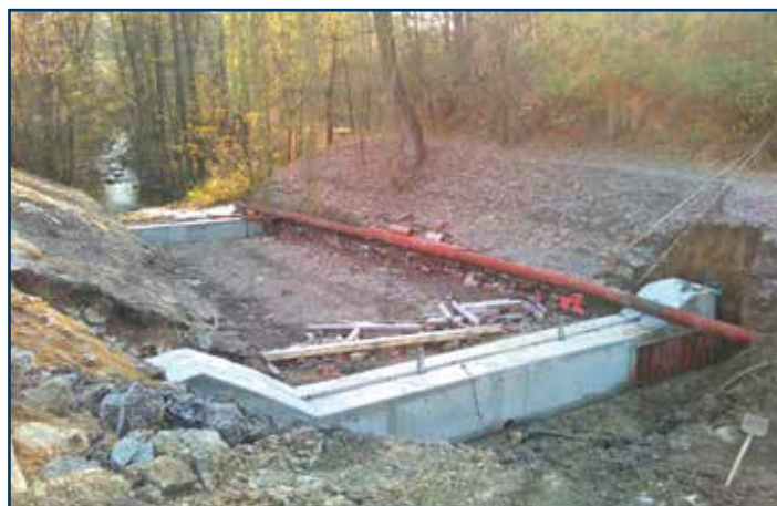
Oprava koryta pod hrází VD Jevišovice
