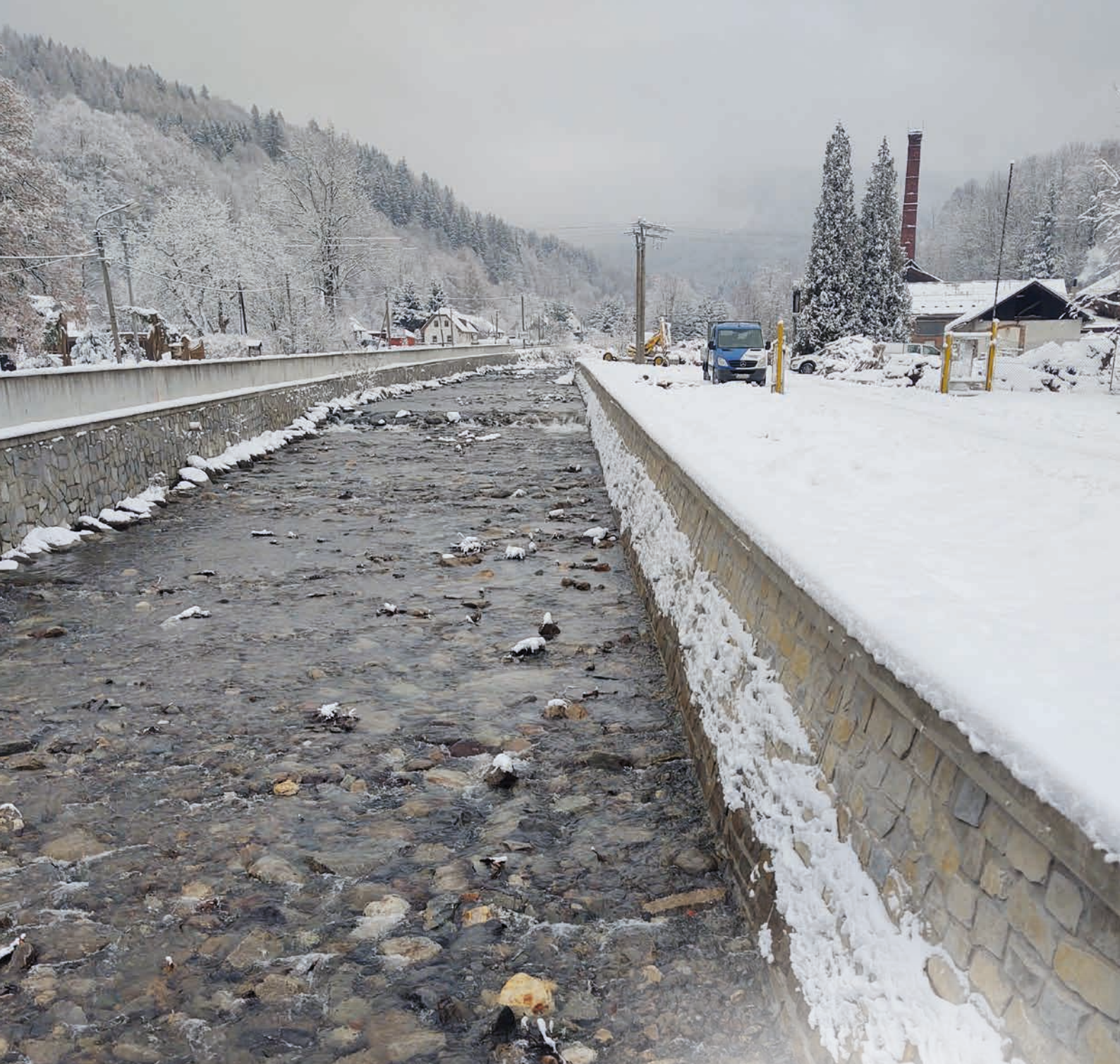
Nová nábřežní zeď vymezuje koryto řeky Desné ↑
