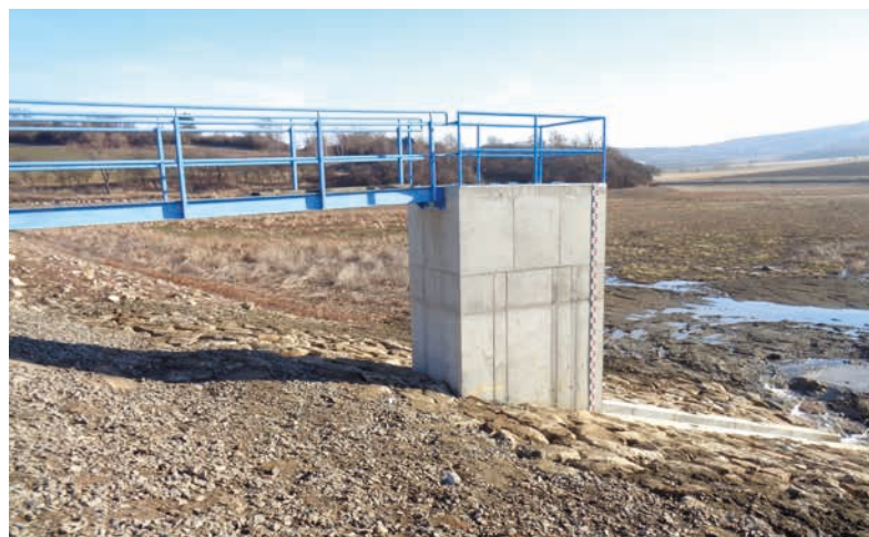
Nové výpustné zařízení VN Ordějov ↑
