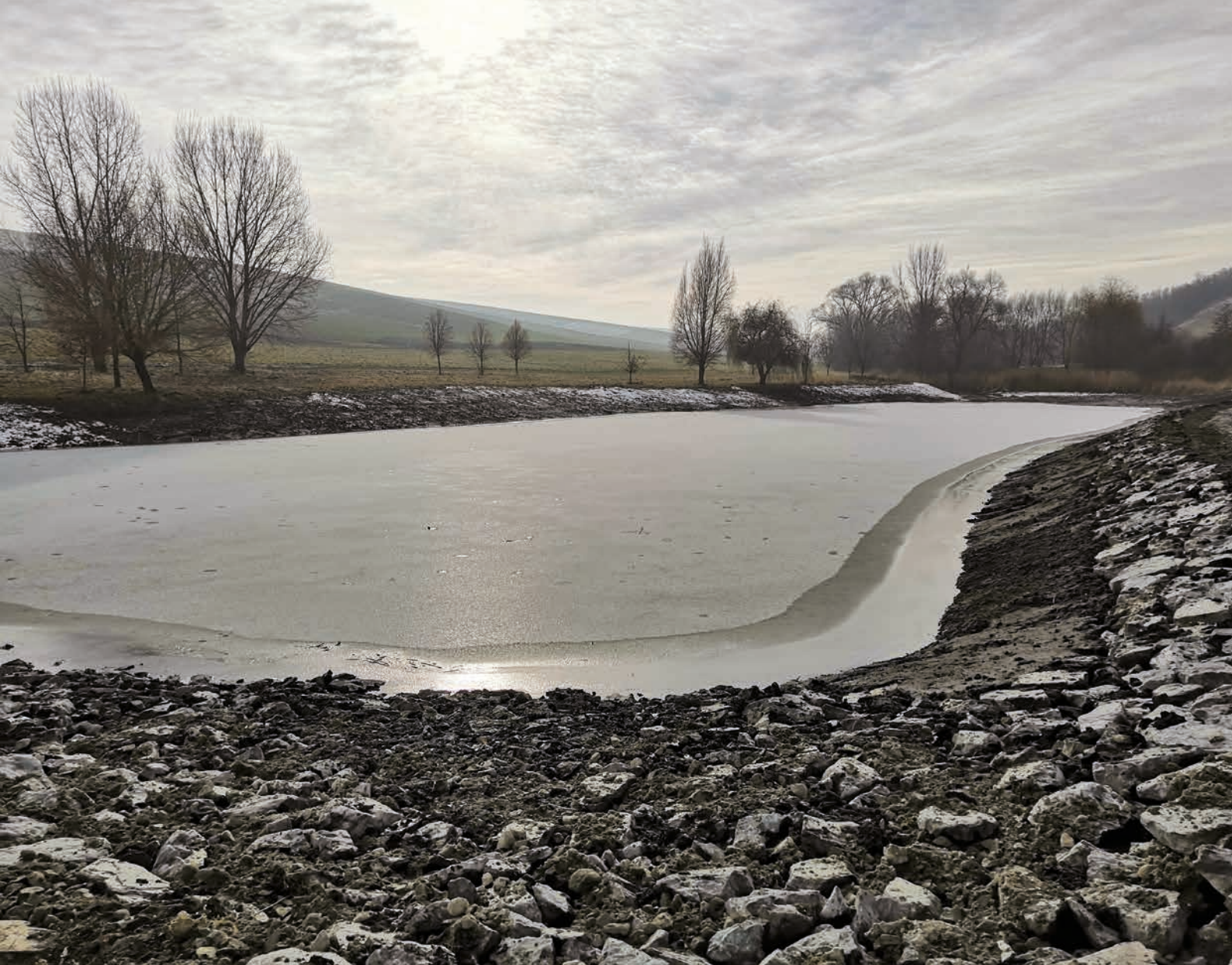
↔ Vodní nádrž Otnice na Brněnsku před a po obnově
