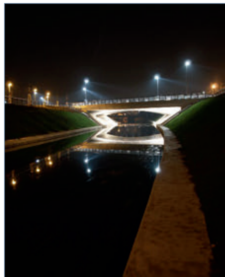
I. etapa – most přes řeku Moravu a obtokový kanál na ulici Wittgensteinova
